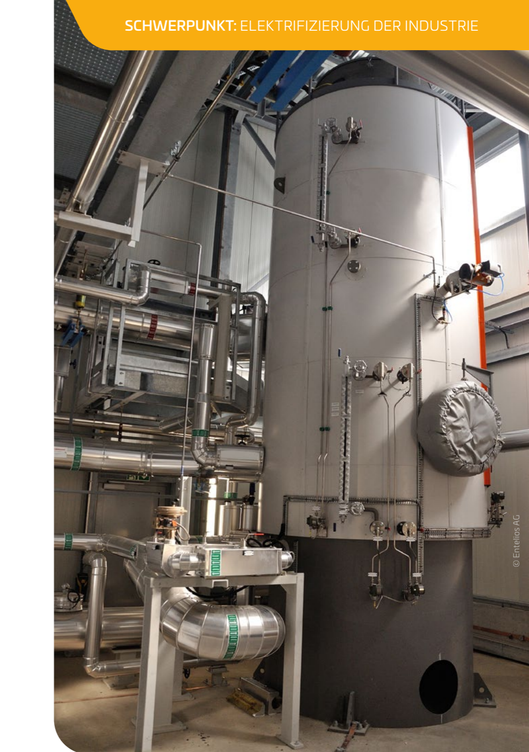
Abb. 2 | Elektrodenkessel, Quelle: Kraftanlagen Energies & Services
